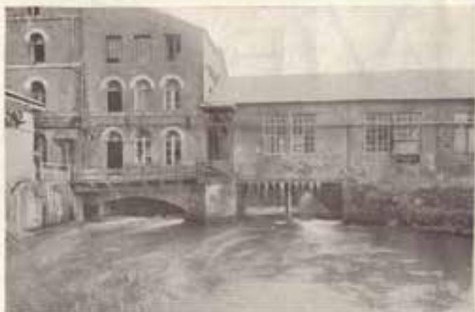
**LA BOUILLE VERTE AU BREUIL-EN-AUGE.** — Rien n'est plus économique dans une grande fromagerie que la force motrice fournie par la rivière. Vous voyez, à gauche, le bief supérieur et le barrage de retenue; à droite, la sortie des eaux et la façade opposée des bâtiments très vastes de la fromagerie, qui étaient occupés autrefois par une minoterie, intelligemment transformée.
